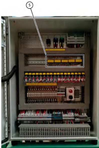
Fig. 148: Remplacer un fusible dans l'armoire électrique
